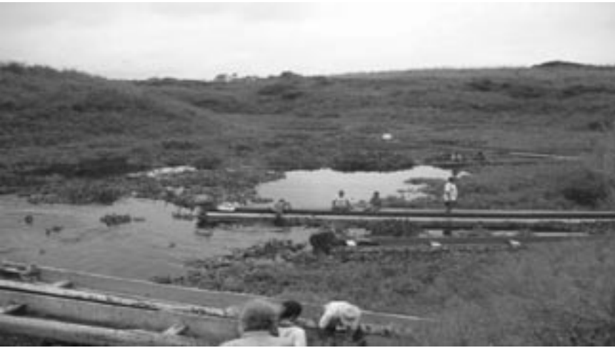
Invasión de lechuguines dificultan la circulación en zonas de la represa Daule-Peripa.
